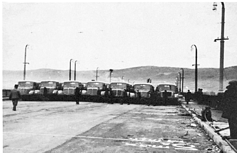
Испытание Коммунального моста, 1961 г
